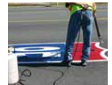
Fig. 7 Caliente el material EF
