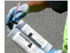
Fig. 4 Prepare los cartuchos de sellador para usar con la pistola selladora.
