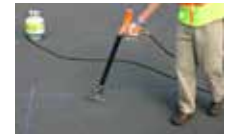
Fig. 3 Después de poner el material a un lado, elimine la humedad del sustrato
