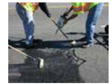
Fig. 5 Vierta el sellador y extienda con un rodillo.
