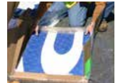
Fig. 1 Manipule las láminas con plástico
