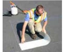
Fig. 2 Trace el material EF Series PFT de acuerdo con el diagrama provisto
