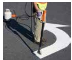
Fig. 3 Coloque el material EF Series PFT de acuerdo con las instrucciones.
