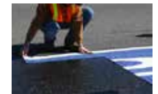
Fig. 6 Coloque el material EF Series PFT de acuerdo con el diagrama provisto.
