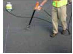
Fig. 1 Prepare el área retirando los desechos con un soplador y, luego, elimine la humedad con un soplete de calor
